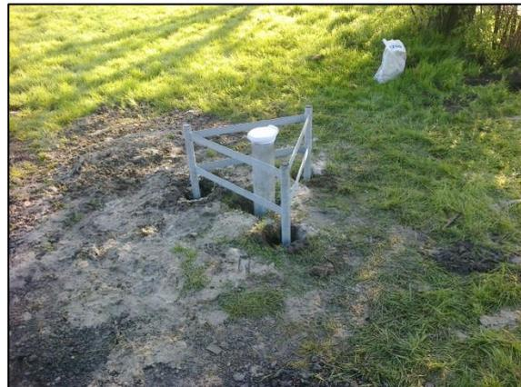
**Foto 14: GWM 1 kurz vor Fertigstellung (Betonage)**
