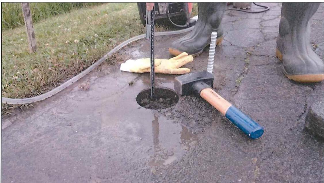
**Bild 2: Asphalt- Kernbohrung an B7**
