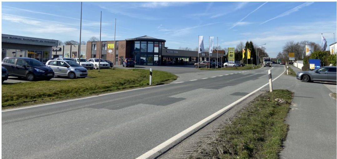
Abbildung 6: Blick entlang der Wittmunder Straße in westliche Richtung
