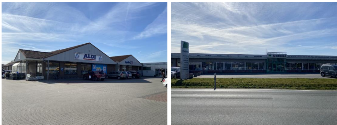
Abbildung 7: Aldi-Altstandort und Elektrofachmarkt Taddicken südlich des Vorhabenareals
