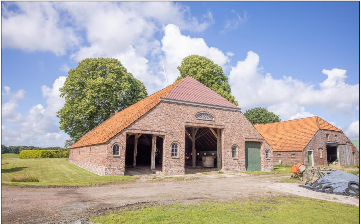
Foto 19: Gulfhof mit Scheune
